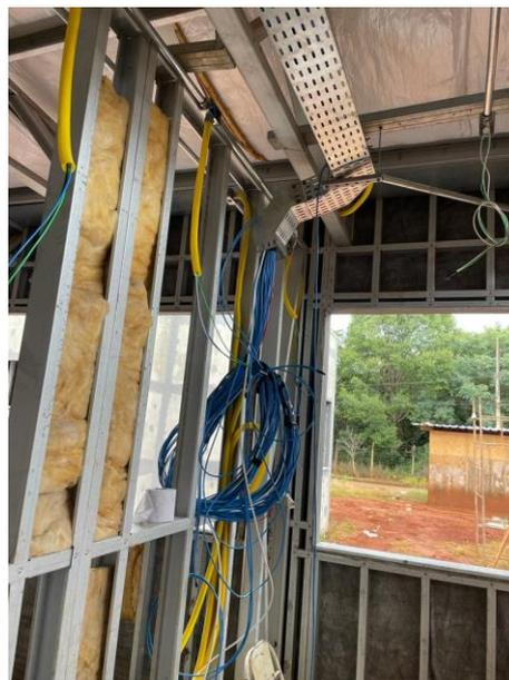
Figuras 1 e 2: Instalação de eletrodutos flexíveis em Estrutura LSF.
